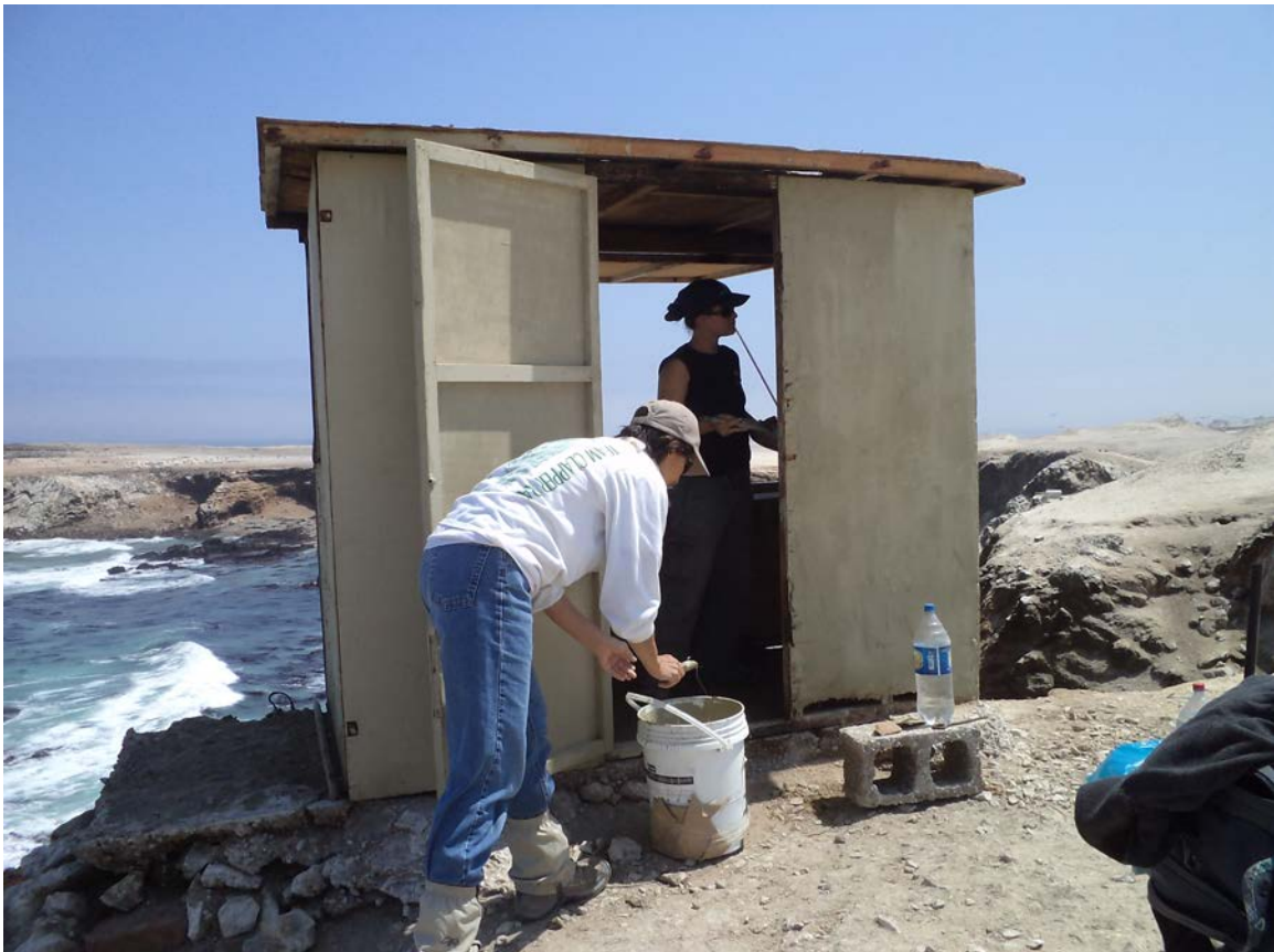
Fotografía 24. Voluntarios reparando las casetas de observación en Punta San Juan.
