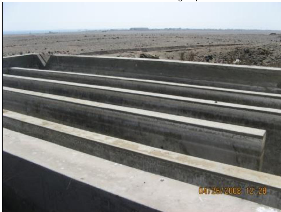
Foto N°09: Planta de sedimentación de agua potable no utilizada
