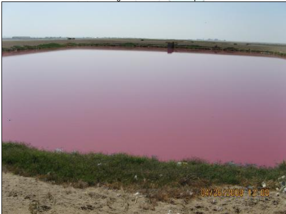
Foto N°04: Laguna de oxidación primaria
