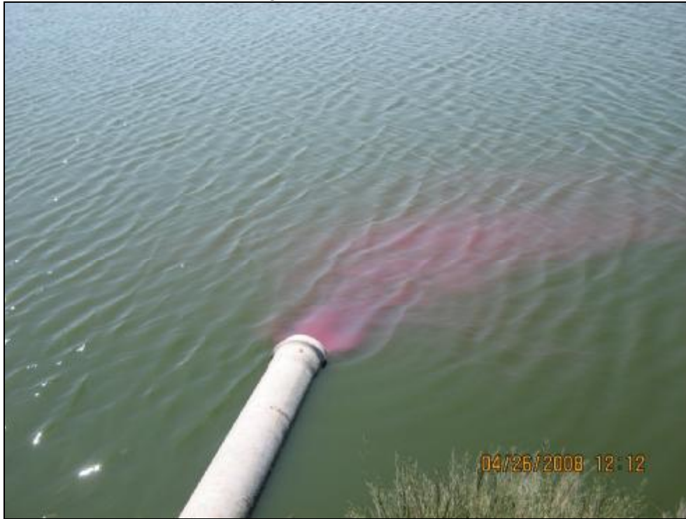
Foto N°07: Laguna de oxidación secundaria
